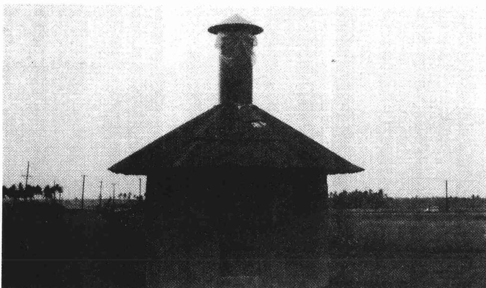
**A6.** Un séchoir à silo modulable permettant de stocker les grains. La cheminée sert à évacuer l'air chaud pour éviter que les grains ne soient abîmés. Le double plancher est perforé de façon à ce que l'air chaud ou froid puisse être insufflé par en bas.
